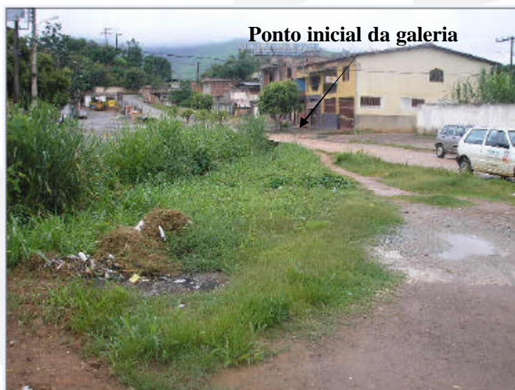
Foto 02: Vista parcial da área onde começará as obras da galeria fechada do afluente do Córrego Caladinho.
