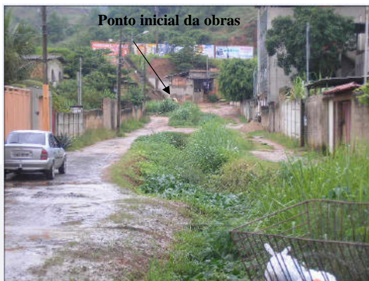
Foto 01: Vista parcial da área onde se dará o início das obras de canalização do afluente do Córrego Caladinho (trecho será construído com manilhas).
