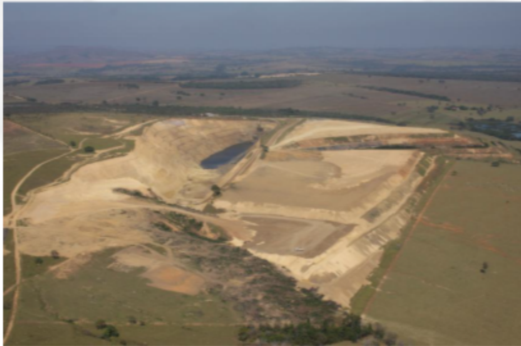
Figura 4: Vista parcial da pilha de Rejeito/Estéril.
