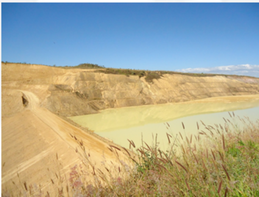
Figura 5: Vista parcial da Barragem de Rejeitos.
