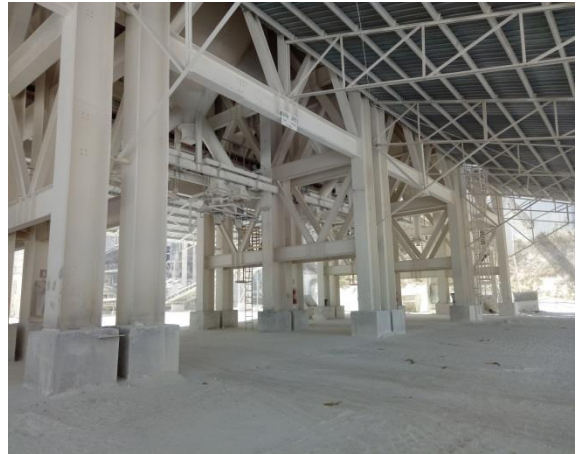
Foto 02. Silos de cal.
