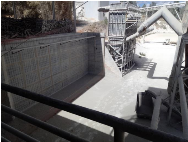
Foto 05. Local onde será instalado o forno IV
