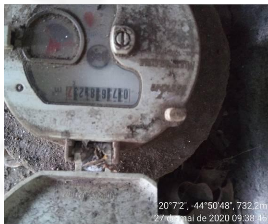
Foto 10. Hidrômetro captação subterrânea.
