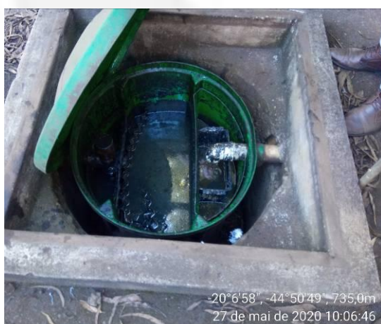
Foto 11. Caixa separadora água/óleo.
