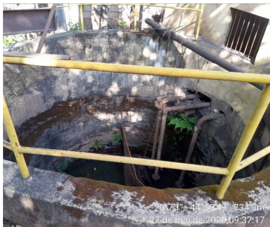
Foto 07. Tanque recirculação de água
