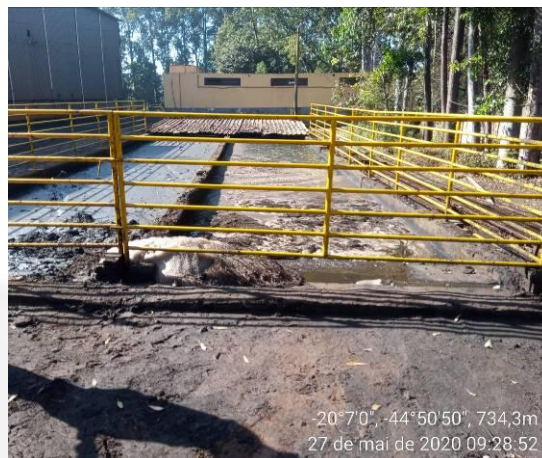
Foto 08. Tanques de lama de alto forno.
