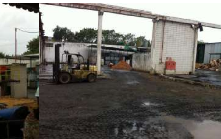
Foto 08. Galpão atualmente utilizado para depósito de biomassa. Local encontra-se destelhado após incêndio ocorrido na empresa. A empresa deverá providenciar a cobertura do galpão.
