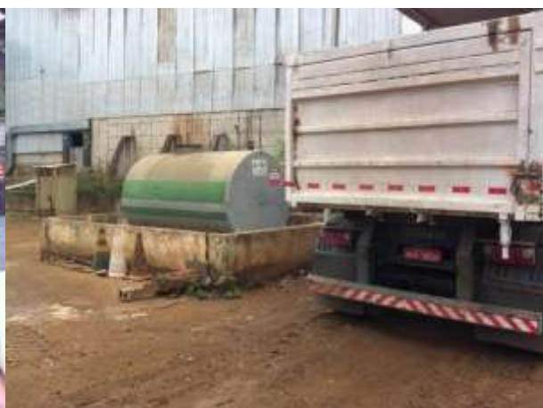
Foto 04. Foto 05. Tanque de abastecimento de óleo diesel regularizado através da AAF 03436/2016.
