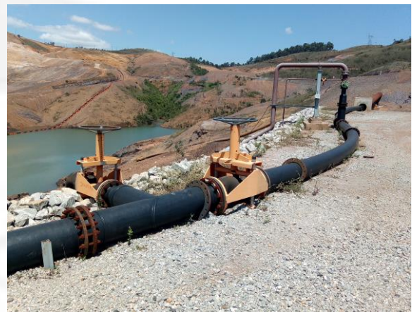
Foto 02. Crista da Barragem com tubulação de rejeito
