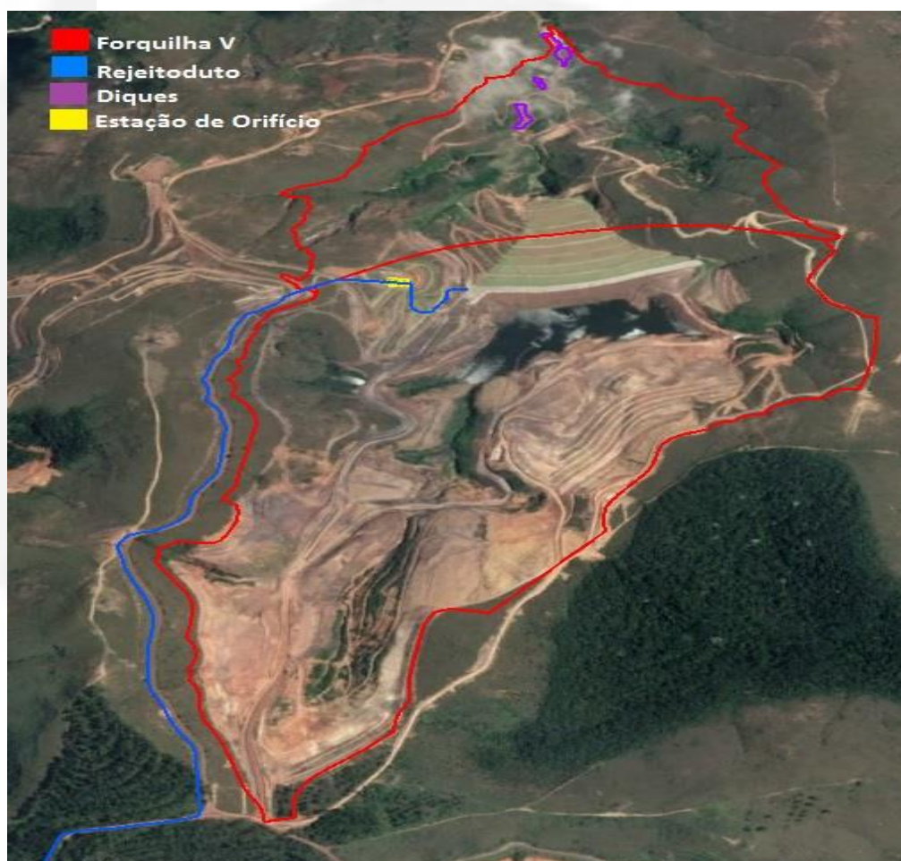
Figura 1: Barragem Forquilha V
