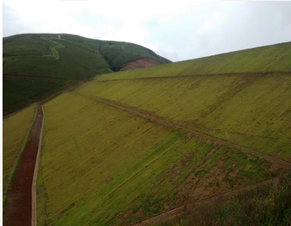
Foto 01. Talude de jusante
