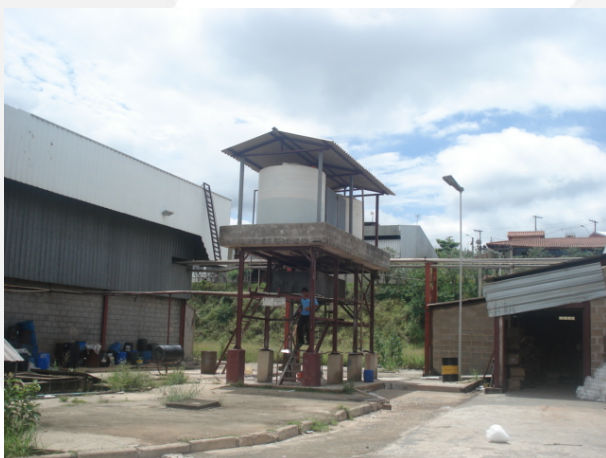
Foto 03. Armazenamento de produtos químicos.
