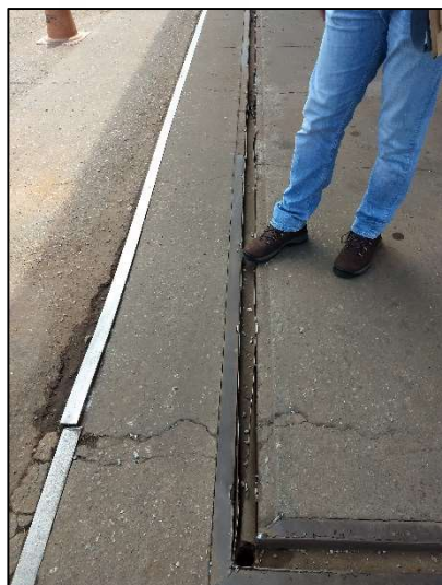
Foto 5: Canaletas de drenagem
