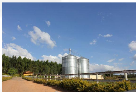
- Silos aéreos armazenamento matéria-prima
