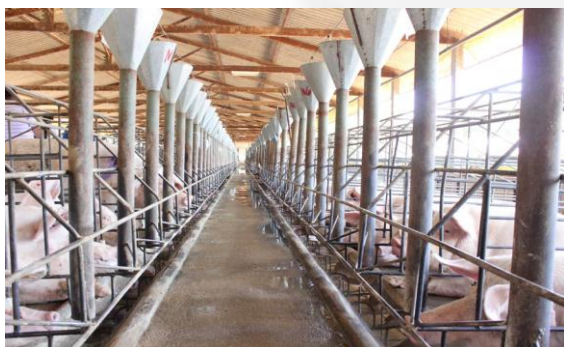
- Vista canaleta escoamento de dejetos
