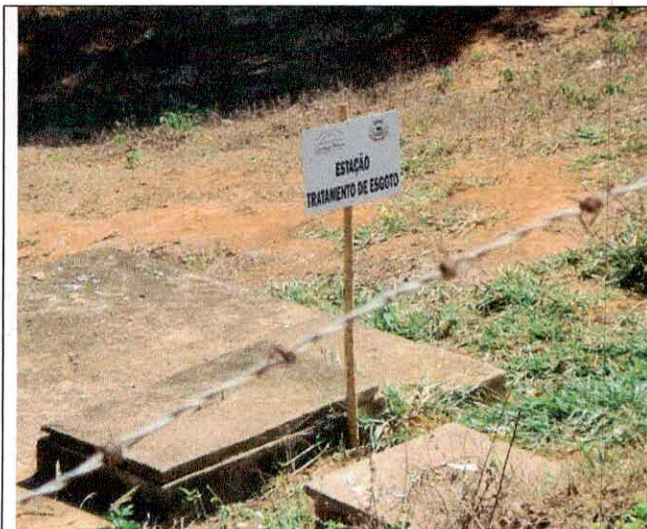
FOTO 19: Estação de tratamento de esgoto/efluente operacional.
