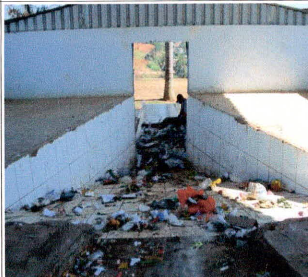
Foto 8: Fosso de recepção dos RSU até a mesa de triagem.
