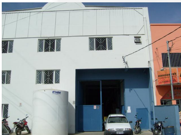
Foto 1. Fachada do Galpão
