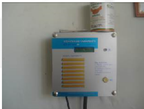
Foto 04. Monitoramento Intersticial realizado em um tanque.
