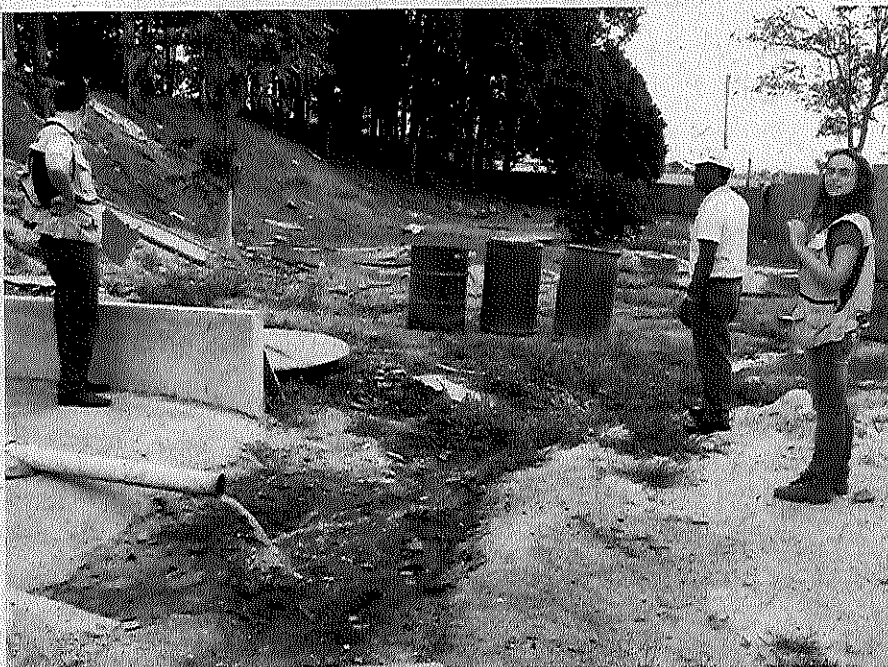
Foto 1: Lodo disposto diretamente no solo (registra feito em ocasião da vistoria realizada em 10/07/2017).
