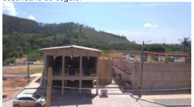
Foto 06: Local destinado à desidratação do lodo por meio de processo mecanizado (centrífugas).
