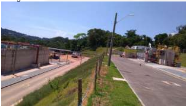
Foto 03: Vista do talude situado entre as etapas de tratamento preliminar e secundário.
