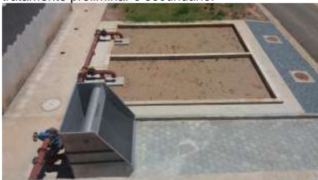
Foto 05: Vista da peneira estática e leitos para secagem da espuma dos reatores UASB.
