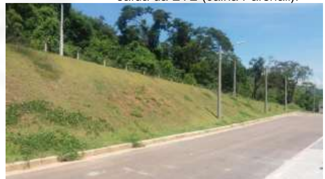
Foto 13: Talude da área interna à ETE, com vista da cerca na parte superior do talude.
