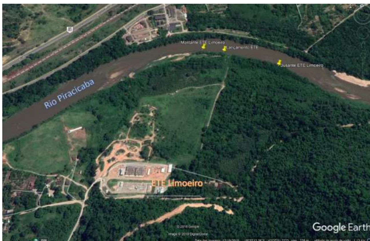
Imagem 01. Vista das obras de implantação da ETE Limoeiro. Fonte: Google Earth.
