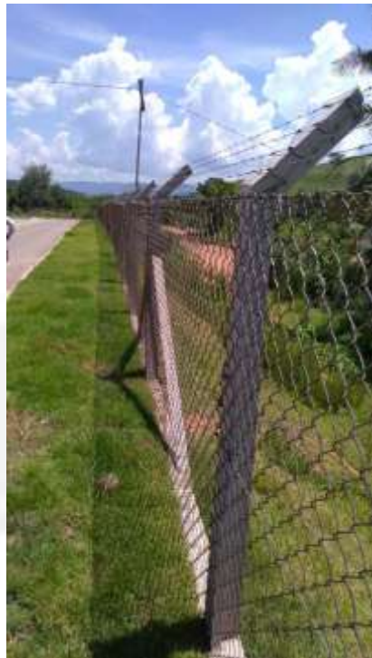
Foto 10: Cercamento da ETE.
