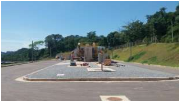
Foto 01: Área interna à ETE, onde está implantado o tratamento preliminar, com vista do talude revegetado.
