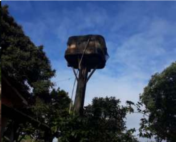
Substituição de caixa d'água
