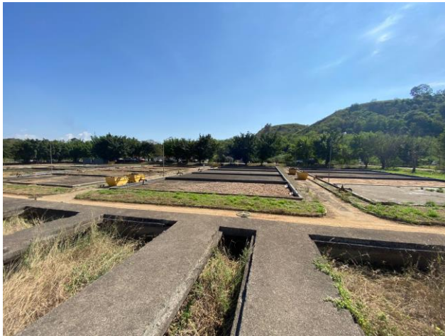
Foto 07: Leito de secagem de lodo.
