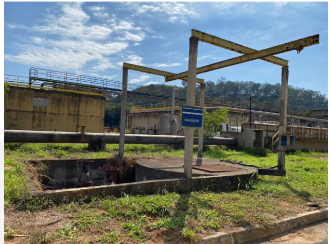
Foto 08: Sistema de drenagem pluvial – Elevatória.
