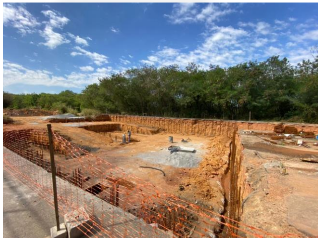
Foto 03: Área de melhorias – Instalação de nova estrutura para Tratamento Preliminar.
