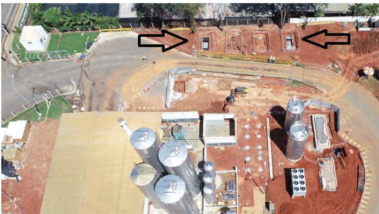
Figura 4- Imagem aérea de 19/11/2025 evidenciando a instalação de diversos equipamentos e estruturas da implantação do empreendimento Nestlé. Obs: Nas setas contidas na imagem encontra-se a fundação para instalação da nova balança. Fonte RCA (Nestlé, 2025).
