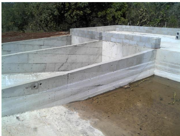
Foto 05. Tanque decantador.
