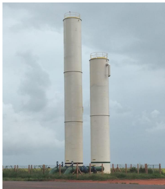
Foto 3: Caixas d'água e efluentes de nivelamento de gravidade
