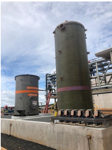
Figura 2-2 -Bacia de contenção e sistema pipe rack
