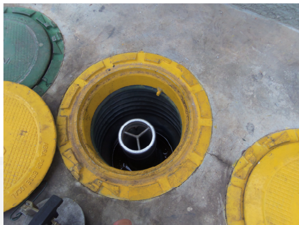
Foto 06- Sump da descarga a distância
