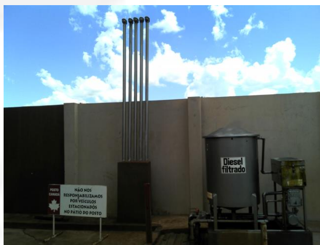
Válvulas de vácuo-pressão dos respiros
