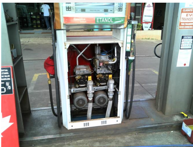
Bomba de combustível: câmara de contenção e válvula de retenção.
