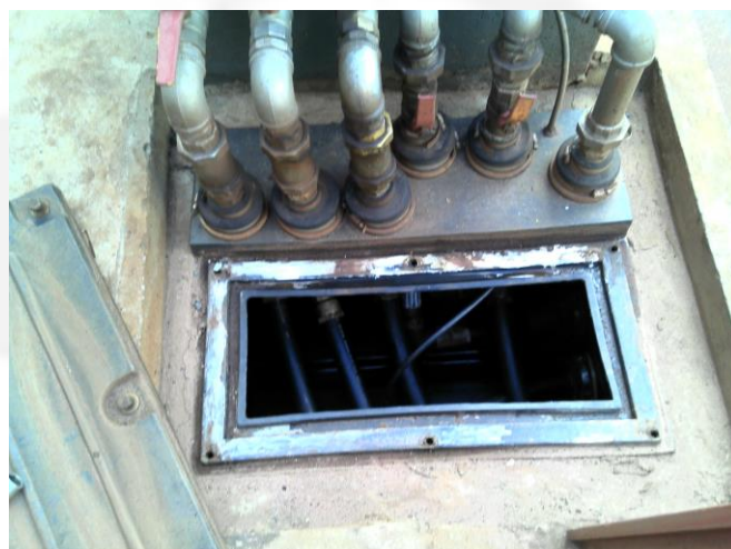
Conexões de descarga: câmara de contenção.
