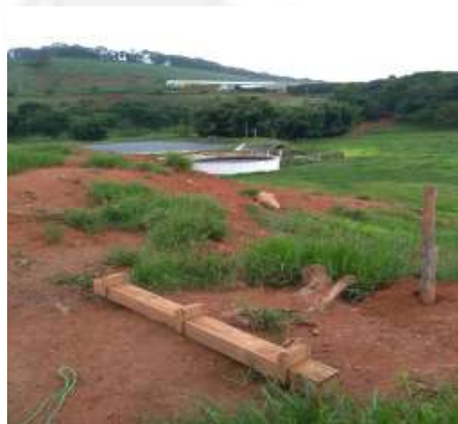
Figura 3: Tanque de recebimento de dejetos
