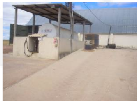
Foto 04. Ponto de Abastecimento e Lavador
