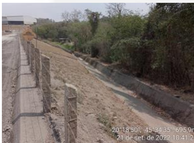
Foto 09. Sistema drenagem barragem B3.
