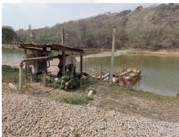
Foto 03. Captação superficial na “Green lake”/Barragem B2.
