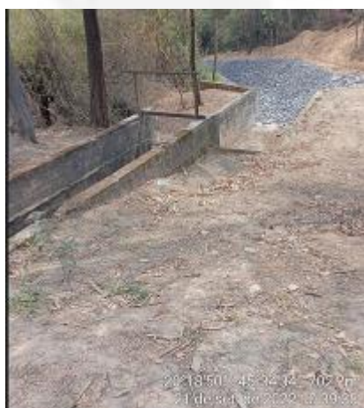
Foto 11. Vertedouro barragem B3.
