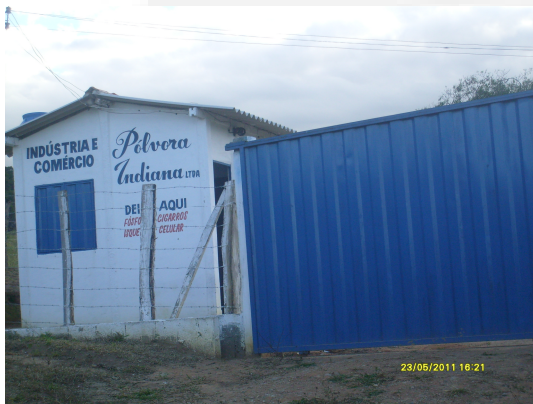
Foto 01. Vista da portaria do empreendimento
