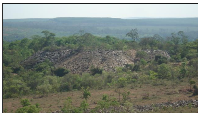
Foto 03: Bota-fora em processo de revegetação. Fonte: Vistoria
