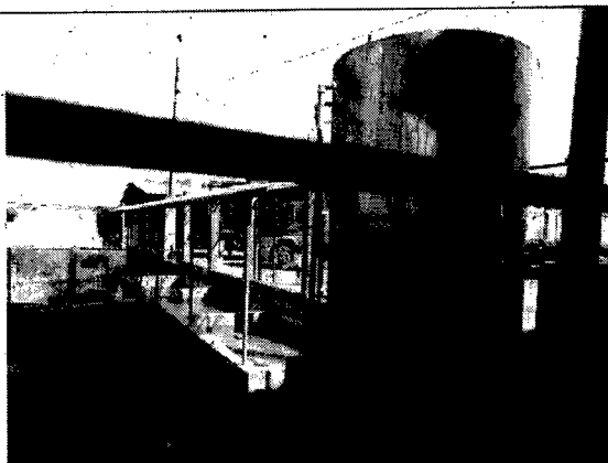
Foto 8: Sistema de tratamento simples e reaproveitamento de efluentes do lavador
