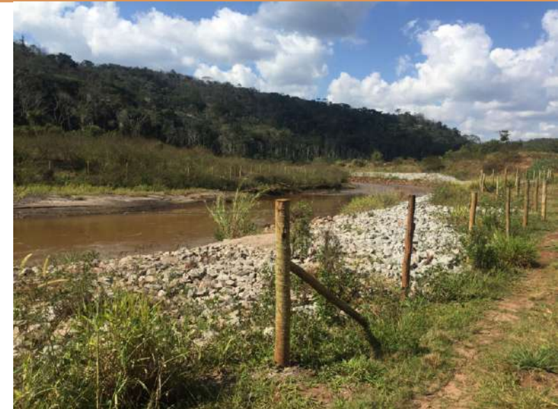
Enrocamento para proteção das margens Fonte: Semad
