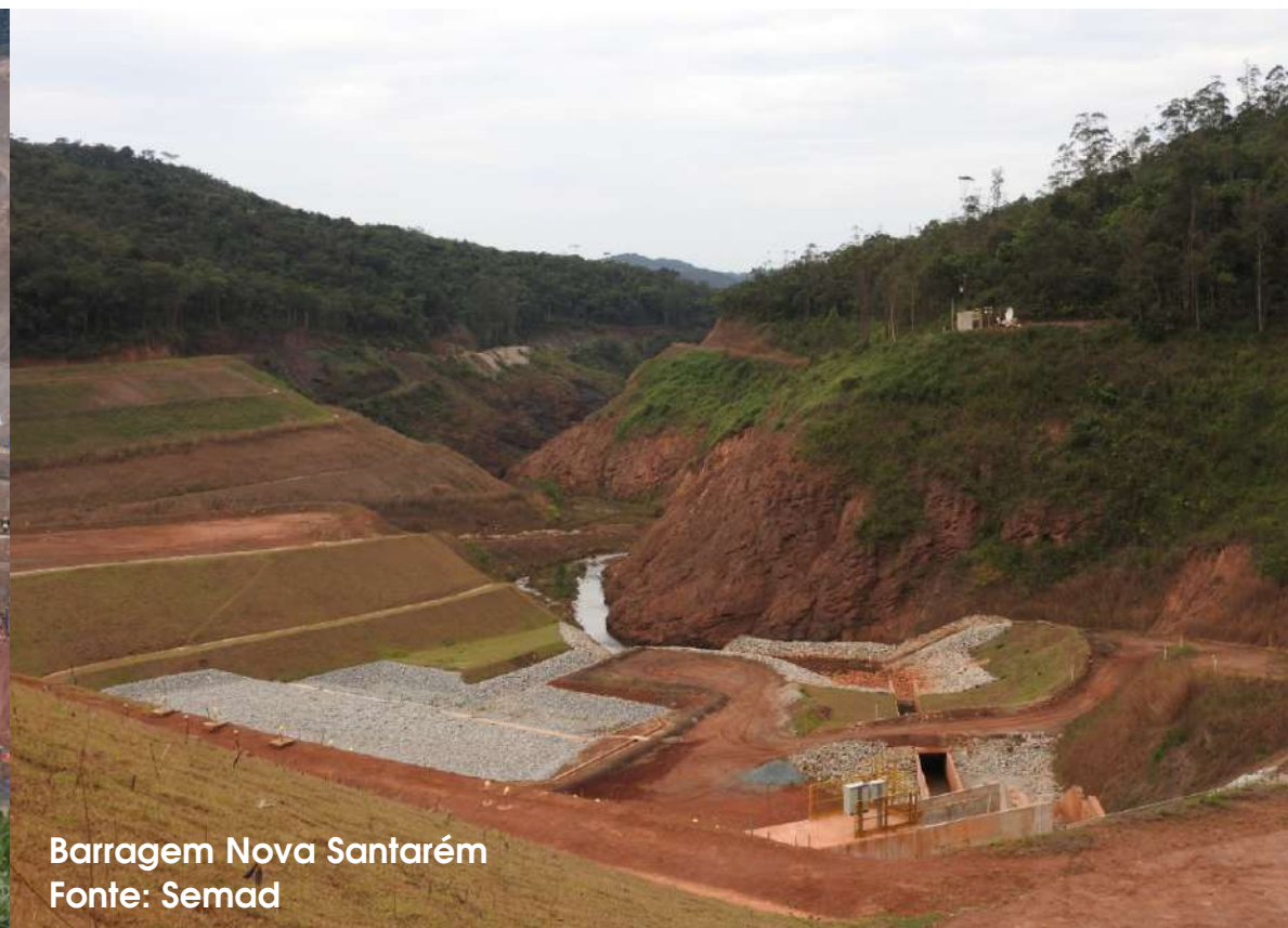
Construção do Eixo 1 Fonte: Semad
