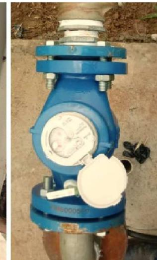
Fotos 8 e 9 – Hidrômetros e horímetro instalados nos pontos de captação hídrica.
