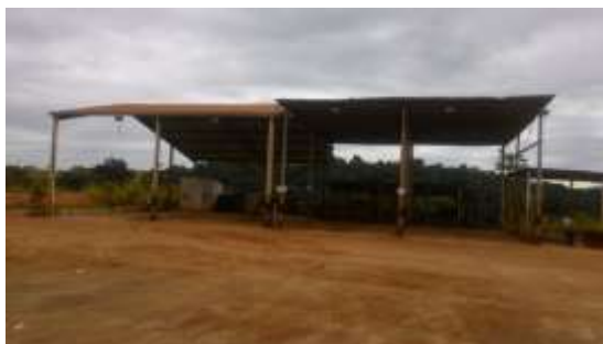
Foto 05: Canteiro de Obras
