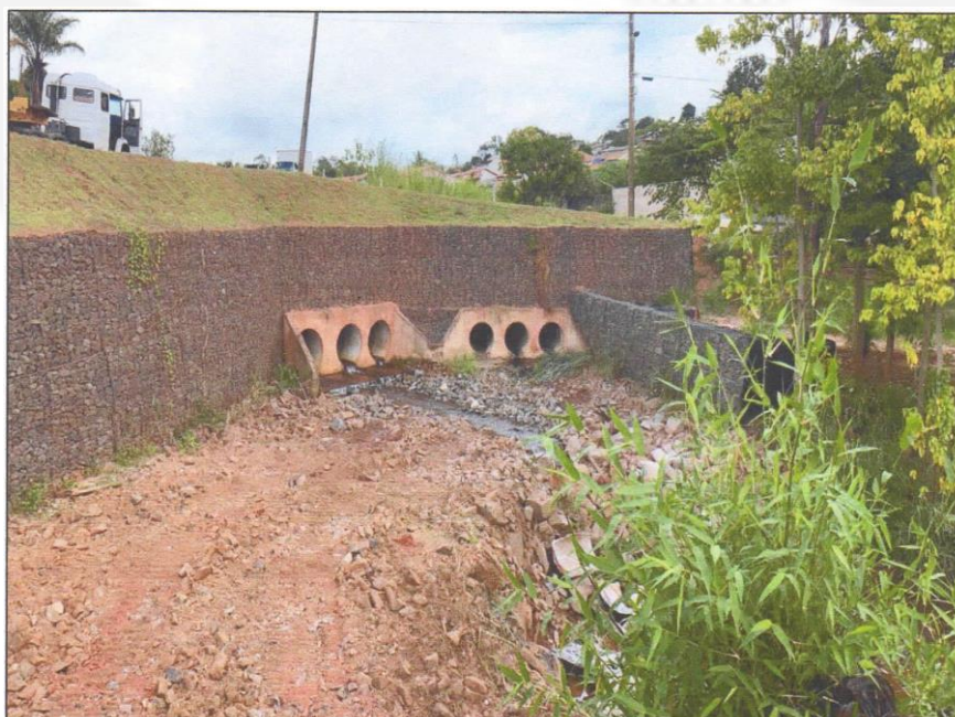
Local onde o córrego do Matadouro deixa a canalização e adentra no empreendimento
