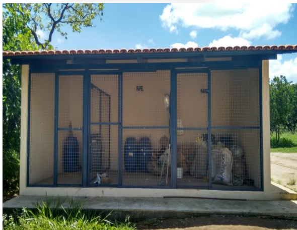
Foto 01. Depósito de resíduos sólidos
