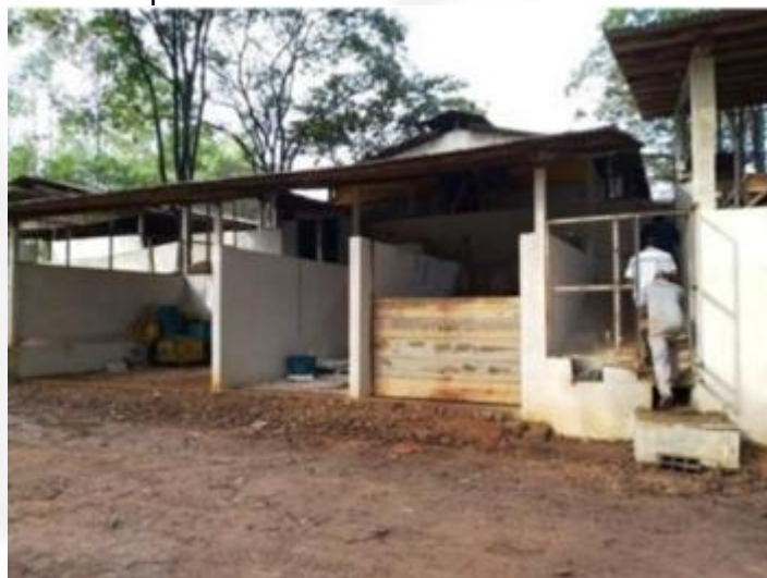
Figura 11 – Câmaras de compostagem, composta com canaleta e caixa de recolhimento de chorume.
