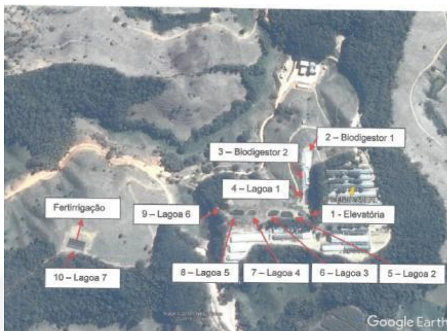
Figura 9 – Ilustração do sistema de tratamento de efluentes instalado no empreendimento, com vista aérea do sistema (Imagem do aplicativo Google Earth).
