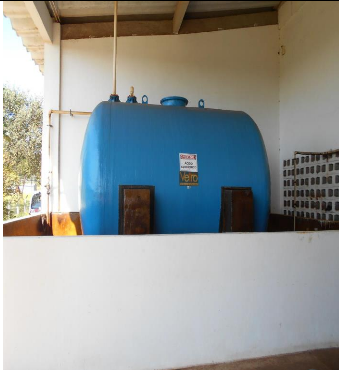
Foto 03 – Tanque de estocagem de ácido clorídrico
