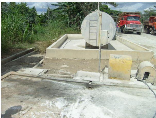
Foto 5. Área de lavagem e tanque de combustível.
