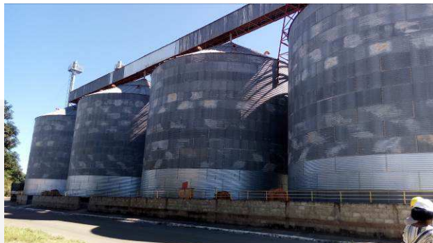
2. Silos de armazenamento
