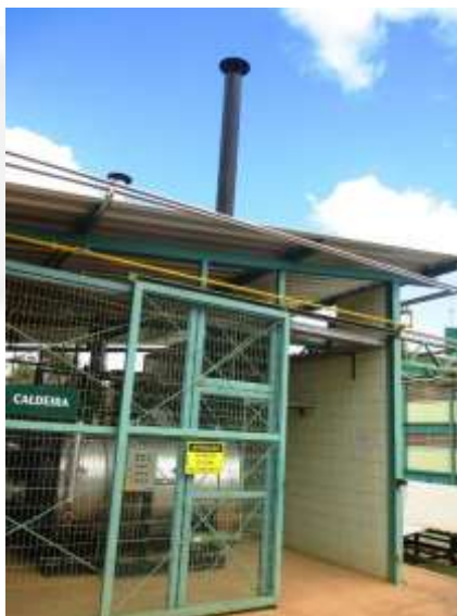
Figura 13 – Caldeira para aquecimento de água de processo.
