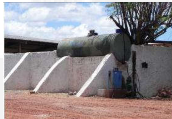
Foto 04. Ponto de abastecimento
