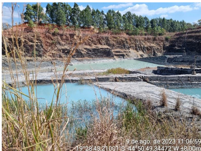
Figura 03: Tanques de decantação das águas residuárias. Fonte: URA NM, 2023.
