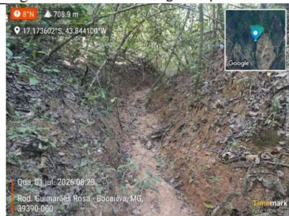
Figura 14. Canal de drenagem superficial.
