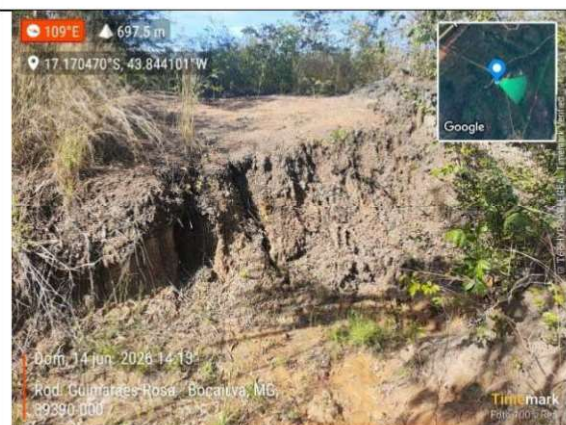
Figura 4. Canal de drenagem superficial.
