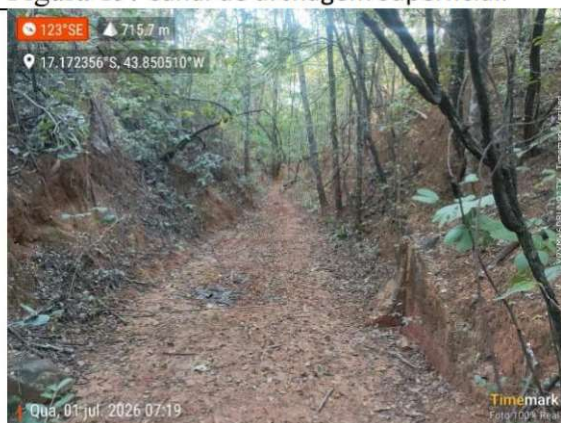
Figura 19. Canal de drenagem superficial.
