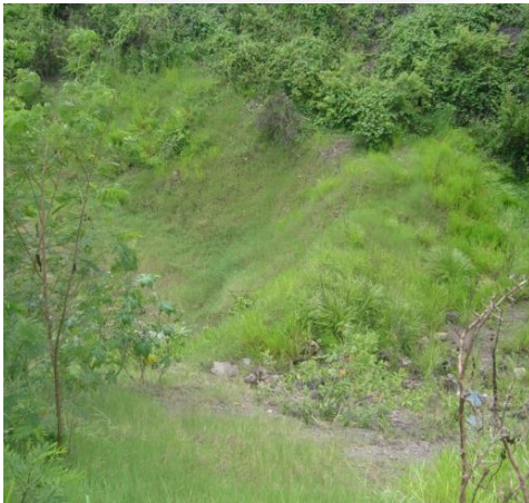
Foto 07. Cacimba para conter os efluentes pluviais.
