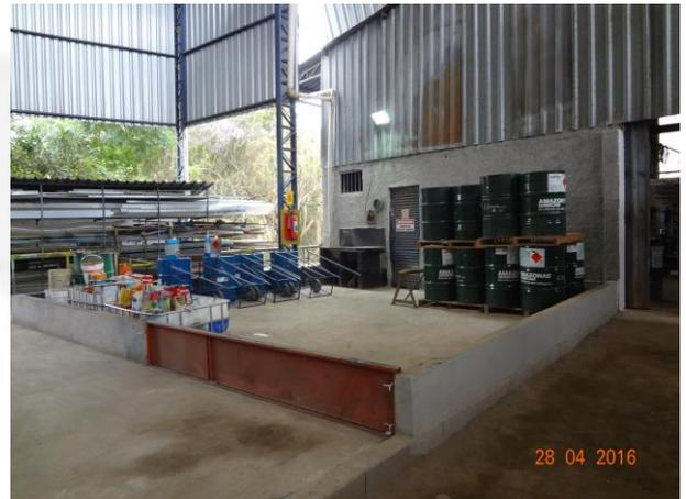
Fig. – Produtos em uso sendo armazenados em local coberto com bacia de contenção e acesso restrito.
