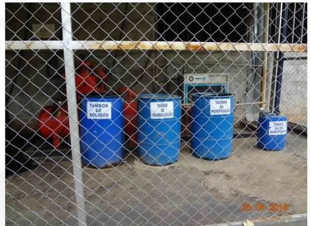
Fig. – Sistema de separação de água e óleo utilizado no empreendimento.
