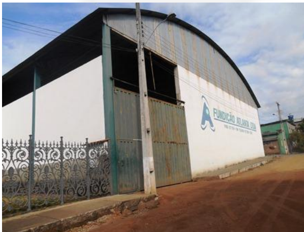
Foto 01. Entrada do empreendimento
