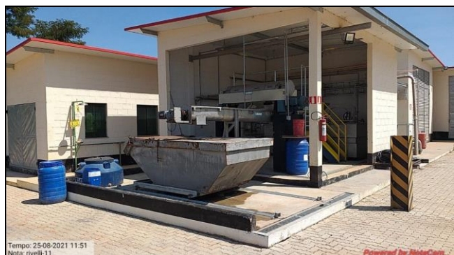
Figura 10: Centrífuga horizontal para desaguamento da massa de lodo.
