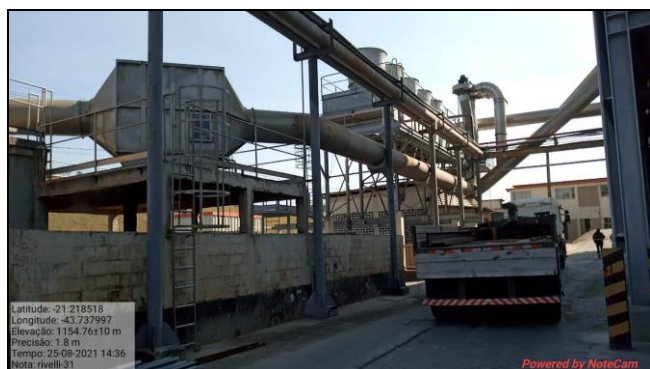
Figura 1: Filtro biológico e aerocondensador – tratamento de gases oriundos da fábrica de farinhas e óleo.
