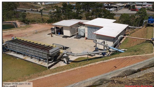
Figura 8: Flotador, laboratório e sala de máquinas da ETE.
