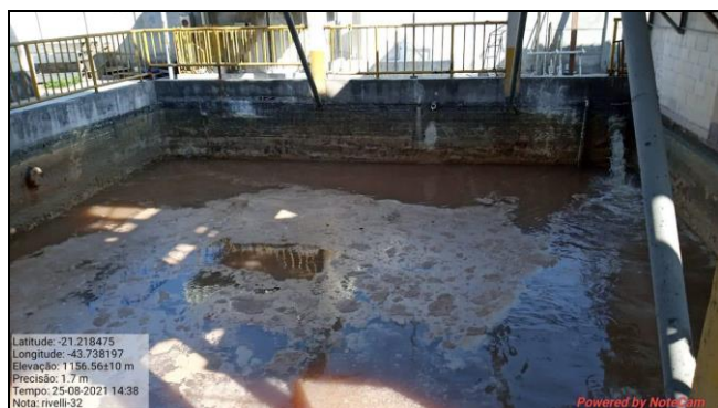
Figura 5: Tanque de equalização da ETE.
