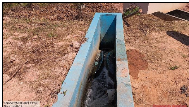
Figura 11: Calha Parshall para medição de vazão do efluente.
