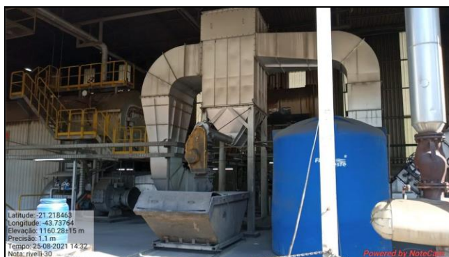
Figura 2: Sistema de controle de emissões atmosféricas da caldeira a lenha e caçamba para coletas de cinza.
