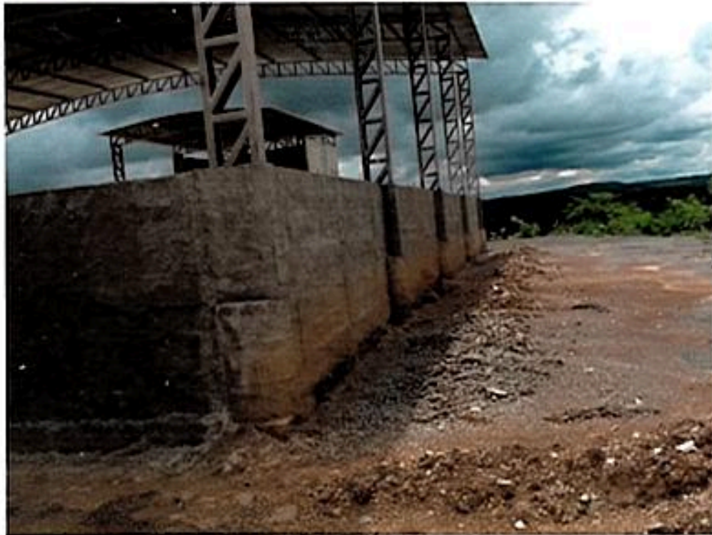
Muro de Vedação Concluído
