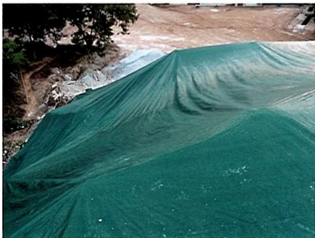
Cobertura das Pilhas Mat. Prima com Lona Leve.
