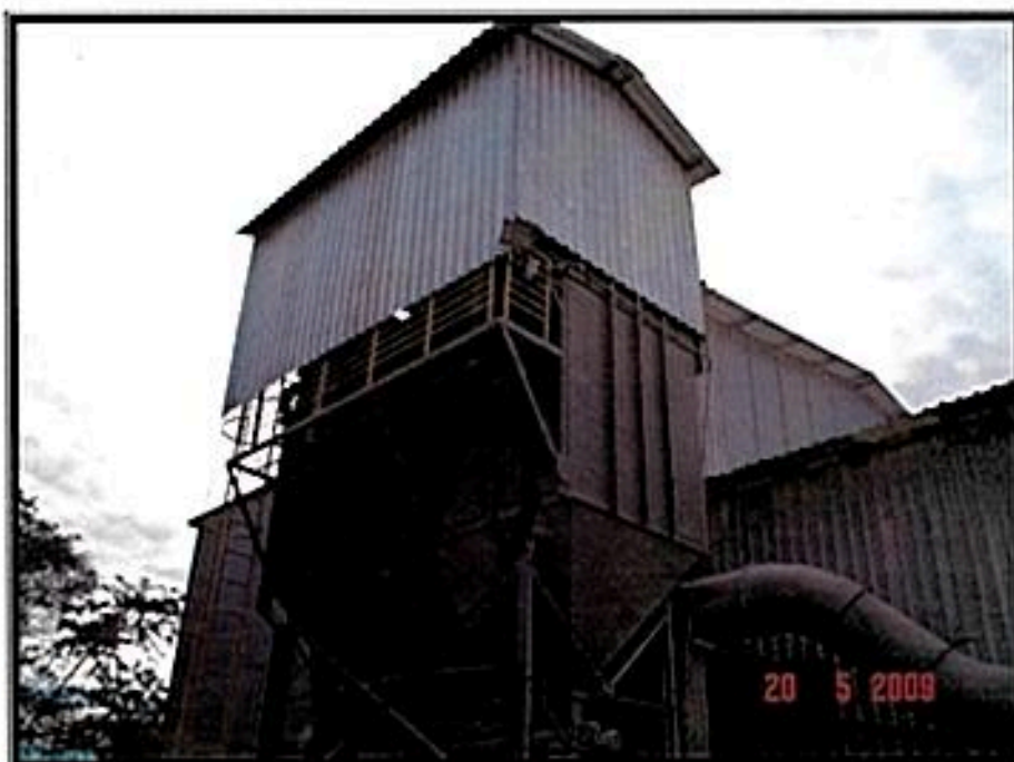
Foto onde podemos observar o filtro do sistema de Despoeiramento e o fechamento do galpão.
