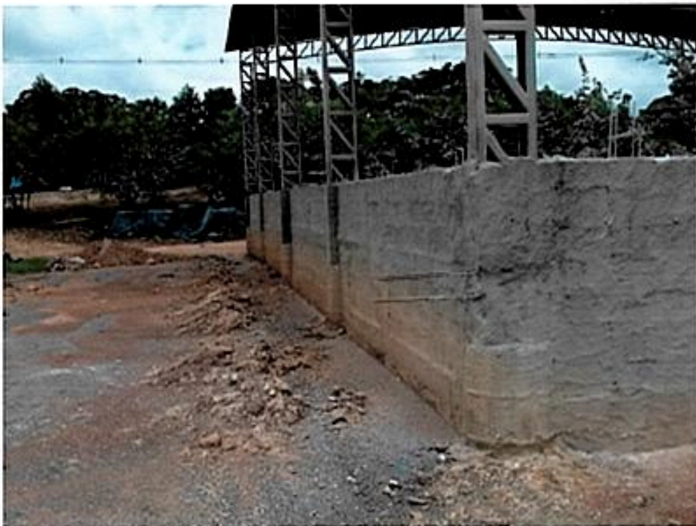
Muro de Vedação Concluído
