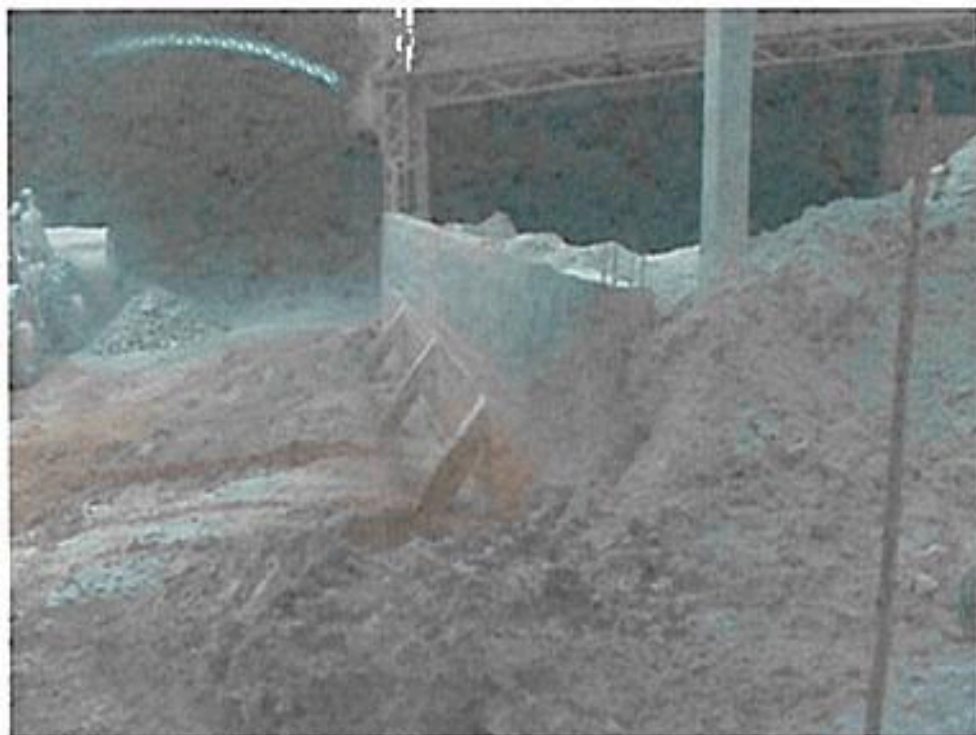
Muro de Vedação
