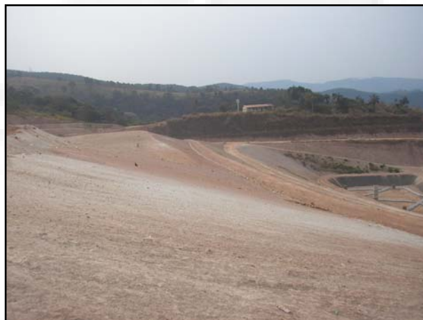
Foto 04: Recuperação do maciço de resíduos antigo.
