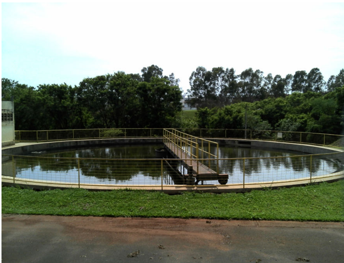
Fig 05: Tanque de decantação
