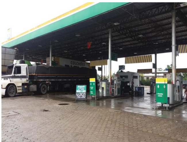
Foto 01 – Vista geral do posto.
