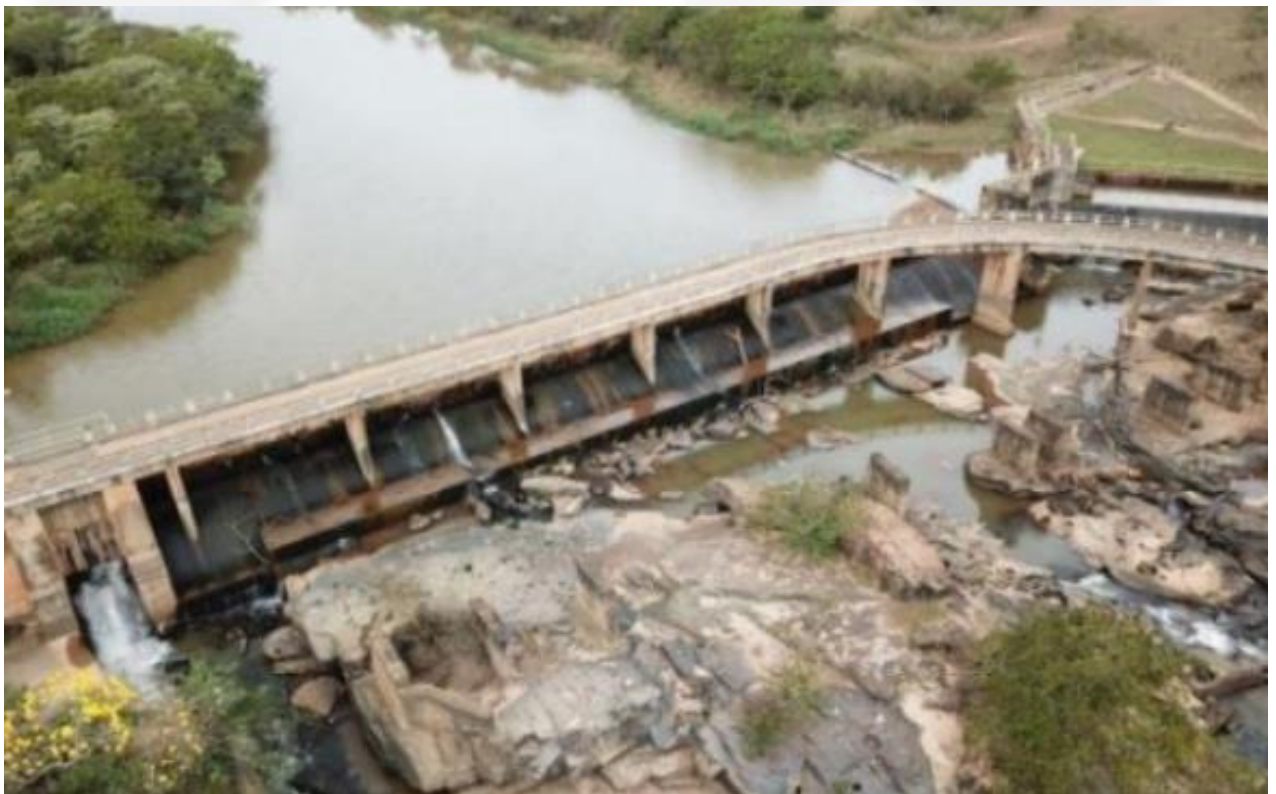
Figura 2: Vista aérea da barragem da CGH Anil
