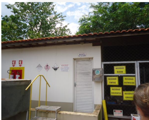
Foto 06. Depósito temporário de produtos perigosos.
